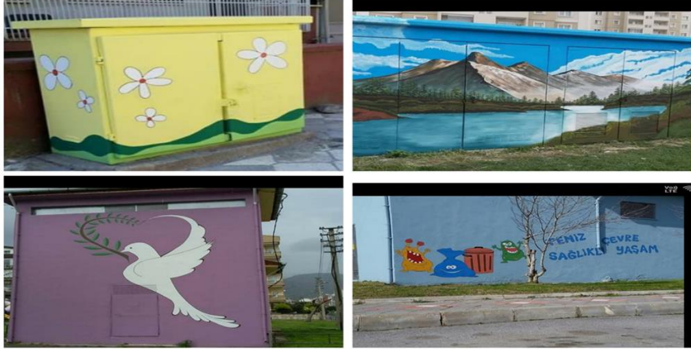
Elektrik Panoları Boyamaları
