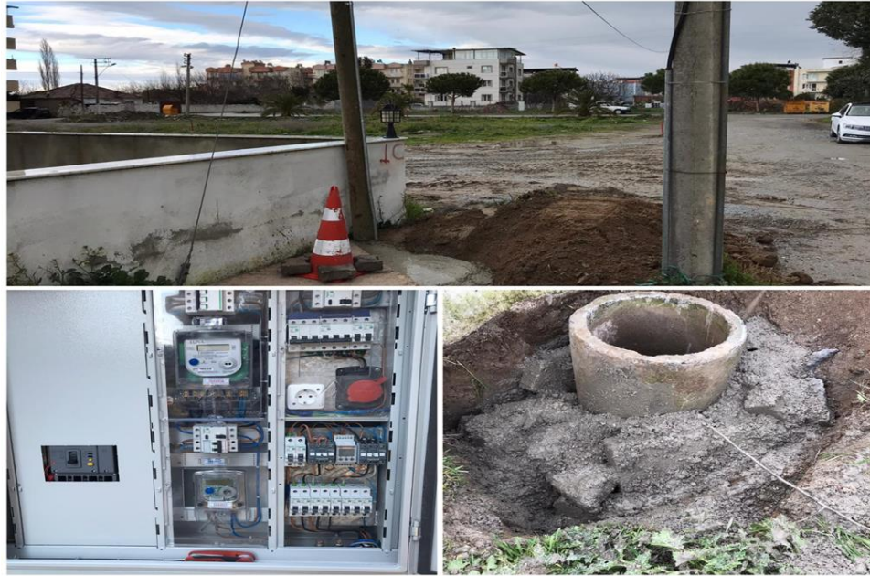
SGK karşısı park Aydınlatma panosu montaj ve devreye alınması- Şantiye çalışmasında yola engel olan direklerin yerlerinin değişimi
