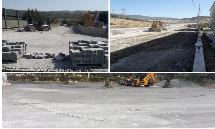
Yenikent Mahallesi 2. Sokak Zeytindalı PARKI Otoparkı–50. Sokak – Recep Oytun Sokak
