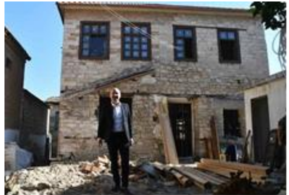
“Atölye Restorasyon Çalışması”
